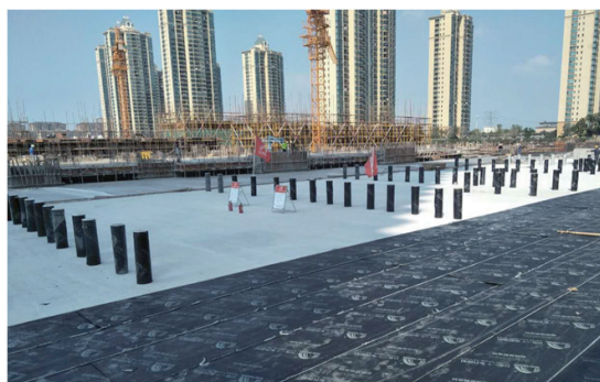
图 5 卷材施工
