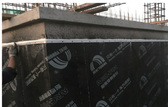
图 7 压条施工
